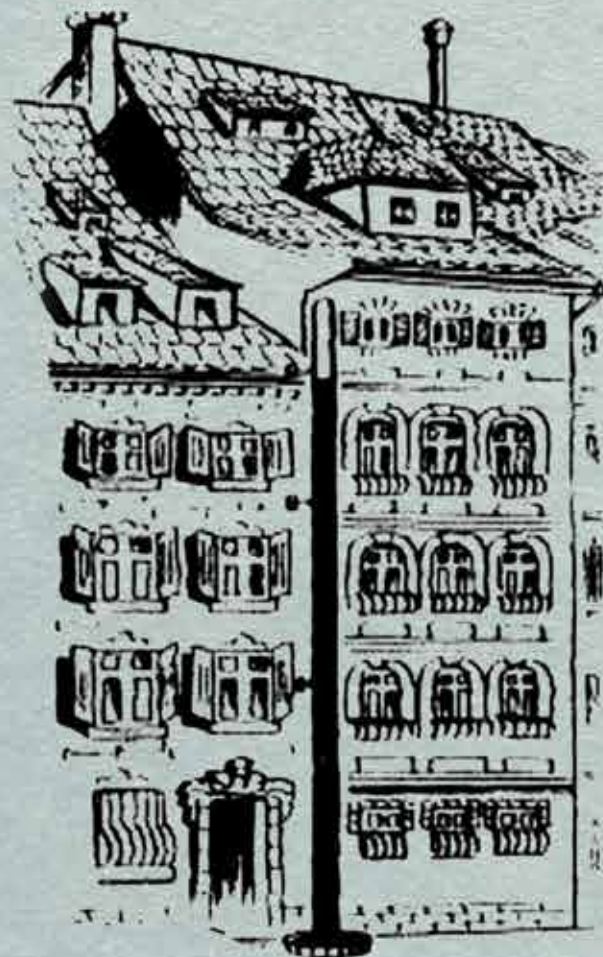
Водный барометр Отто фон Герике. 1660 год
