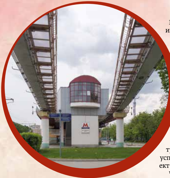
Станция «Выставочный центр»
