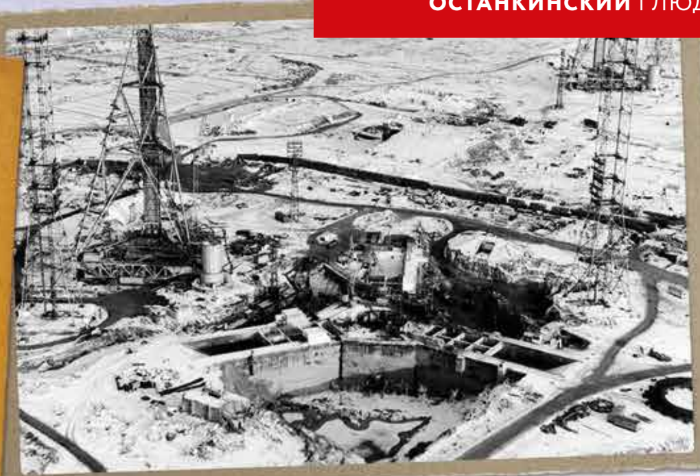
Строительство космодрома Байконур, 1955 год
