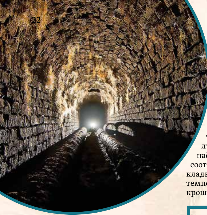
Галерея Мытищинского водопровода с трубами по проекту Дельвига. Фото undergroundfoto.livejournal.com
