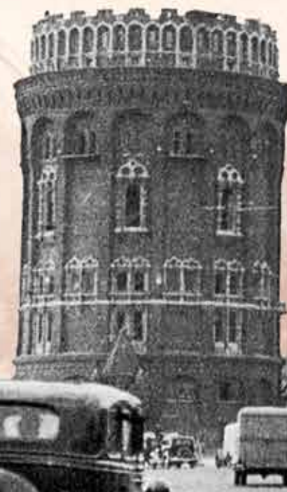
Разрушение Крестовских башен, 1940 год
